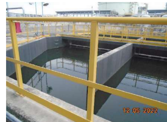
รูปที่ 2-12 ระบบแยกน้ำมันของสถานีสับ-จ่ายก๊าซธรรมชาติเหลว
