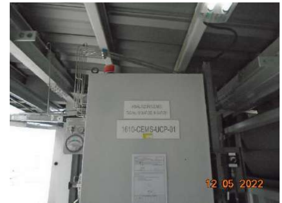
รูปที่ 2-6 เครื่องมือควบคุมระบบตรวจสอบมลพิษทางอากาศ แบบต่อเนื่อง (CEMs)
