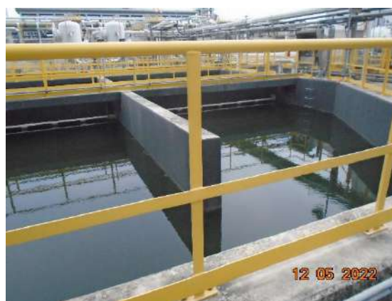
รูปที่ 1-7 ระบบ CPI Separator
