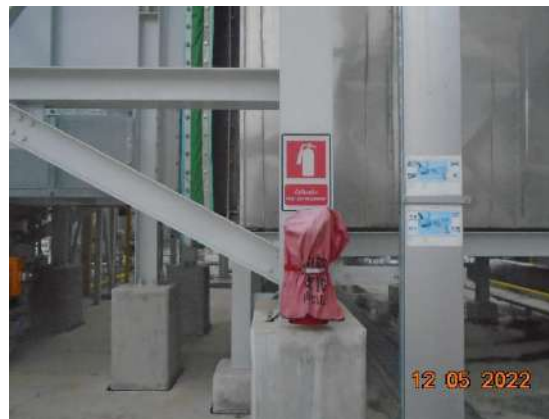
รูปที่ 2-23 เครื่องมือดับเพลิงขั้นต้นชนิดผงเคมีแห้ง
