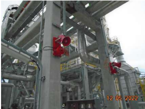
รูปที่ 2-25 สัญญาณแจ้งเหตุเพลิงไหม้
