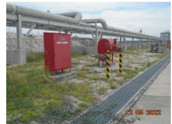
รูปที่ 2-24 หัวจ่ายน้ำดับเพลิงและตู้ดับเพลิงพร้อมสายน้ำ
