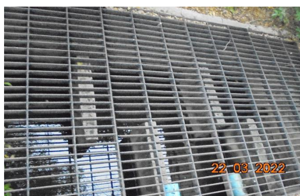
รูปที่ 2-13 ตะแกรงเหล็กปิดไว้ในท่อระบายน้ำรวม ของโครงการ
