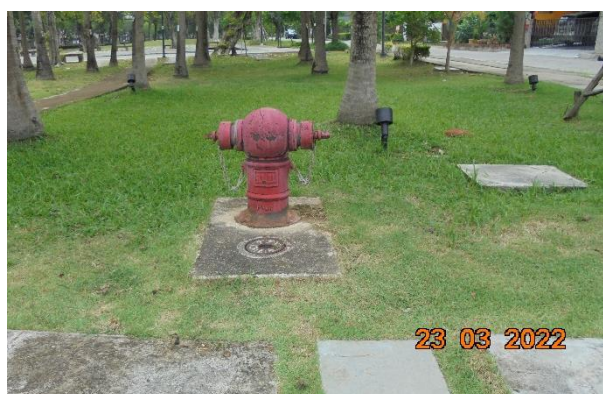
รูปที่ 2-21 ติดตั้งหัวจ่ายน้ำดับเพลิงให้ครอบคลุม พื้นที่ทั้งหมดของโครงการ
