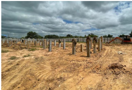
รูปที่ 7 วัสดุดูดซับเสียงรบกวนหุ้มเสาเข็ม
