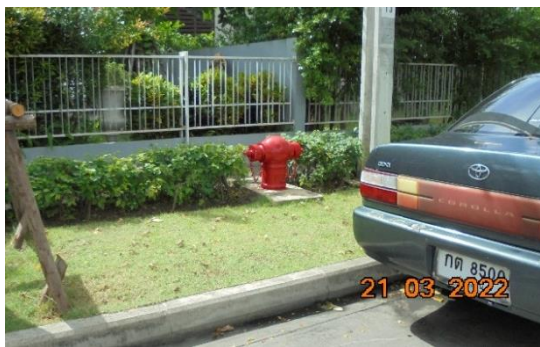
รูปที่ 2-16 หัวดับเพลิง (Fire Hydrant) ที่ได้ติดตั้งในพื้นที่ 1
