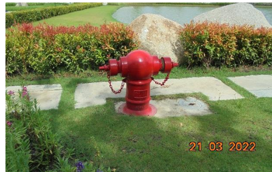
รูปที่ 2-16 หัวดับเพลิง (Fire Hydrant) ที่ได้ติดตั้งในพื้นที่ 1
