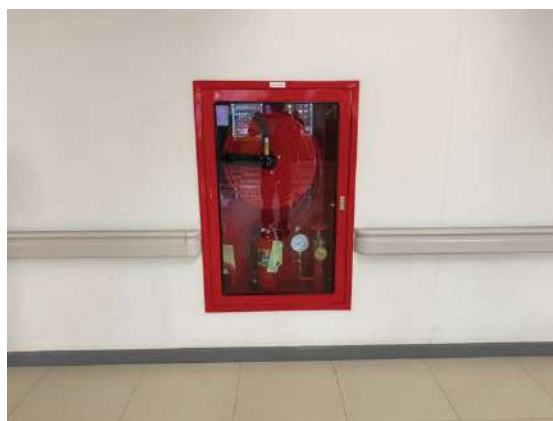
ตู้สายฉีดน้ำดับเพลิง FHC
