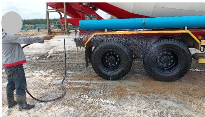
รูปที่ 5 การล้างทำความสะอาดล้อรถบรรทุก
