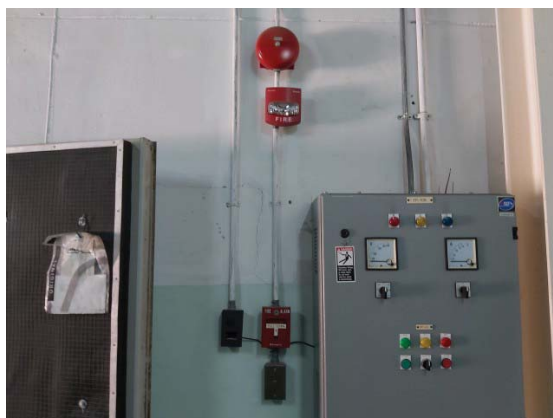
รูปที่ 3 ตู้ควบคุมระบบบำบัดน้ำเสีย
