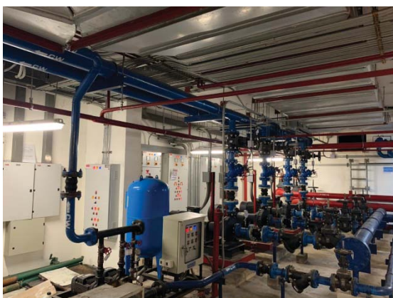
รูปที่ 12 ระบบสูบ-จ่าย น้ำประปา
