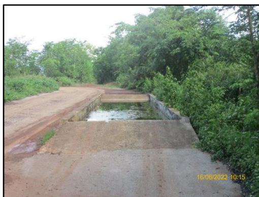
ภาพที่ 2.7 บ่อล้างล้อรถบรรทุกที่ขนส่งแร่
