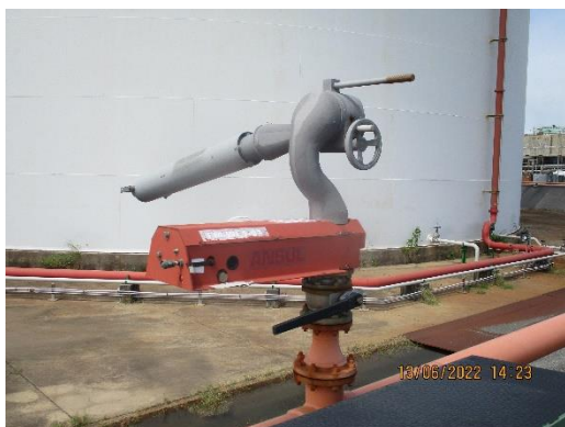
ภาพที่ 2-83 Fixed Foam Monitor
