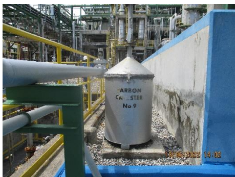
ภาพที่ 2-13 Carbon Canister ที่ Caustic Drain Drum
