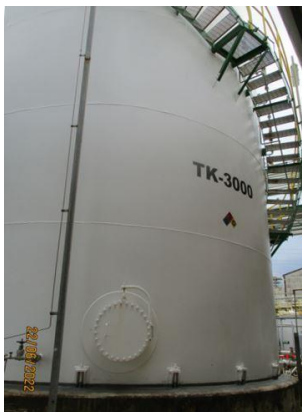
ภาพที่ 2-19 Oily Holding Tank
