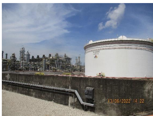
ภาพที่ 2-33 คันกัน (Dike) บริเวณลานถังเก็บแนฟทา (TK-1000C)
