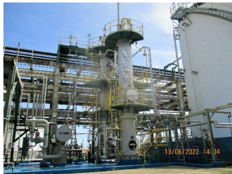
ภาพที่ 2-8 Spent Caustic Wash Tower
