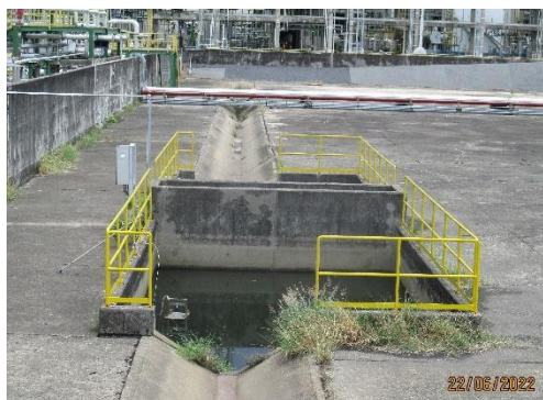
ภาพที่ 2-35 Storm Water Diversion Box บริเวณลานถังเก็บแนฟทา (TK-1000C)
