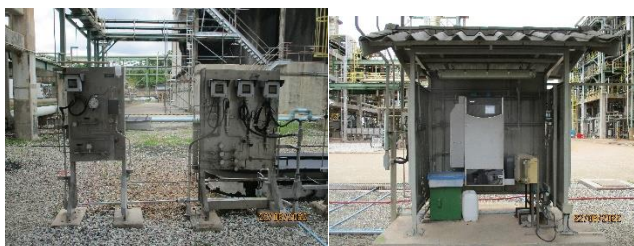
ภาพที่ 2-40 TOC และ pH Online Analyzer
