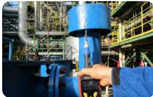
การตรวจวัดจุดระบายออกของ Carbon Canister
