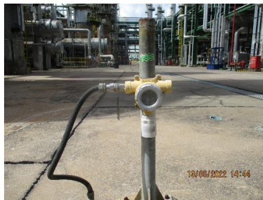
ภาพที่ 2-93 Flammable Gas Detector
