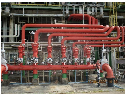
ภาพที่ 2-92 Fixed Water Spray System
