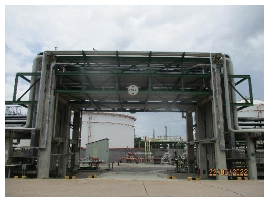
ภาพที่ 2-100 ระบบท่อที่วางบนโครงสร้าง รองรับระบบท่อ
