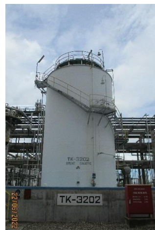
ภาพที่ 2-16 Spent Caustic Tank
