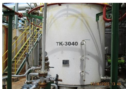
ภาพที่ 2-18 Slop Oil Tank
