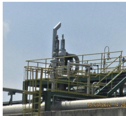
ภาพที่ 2-103 อุปกรณ์ระบายความดันอัตโนมัติ (PSV)
