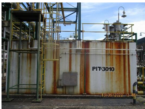
ภาพที่ 2-21 CPI Separator
