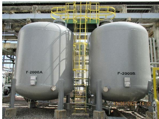
ภาพที่ 2-26 Sand Filter
