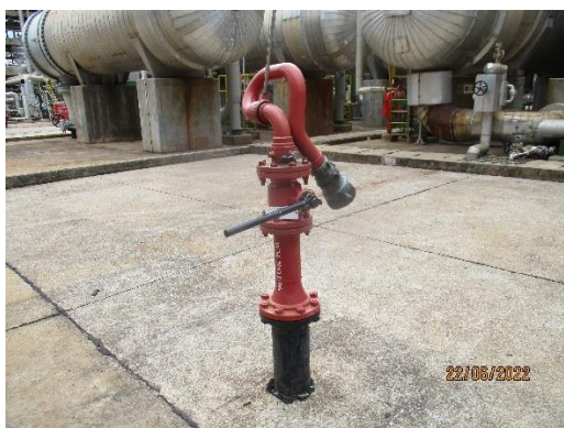
ภาพที่ 2-94 Fire Water Monitor
