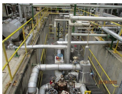
ภาพที่ 2-48 Light Oil Drain Drum สำหรับเก็บ Gasoline ที่ผ่านการใช้ล้างสารประกอบไฮโดรคาร์บอน
