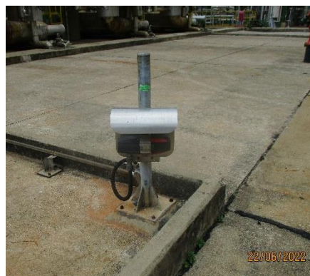
ภาพที่ 2-76 Gas Detector
