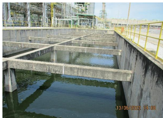
ภาพที่ 2-30 บ่อตรวจสอบคุณภาพ (Diversion Box)
