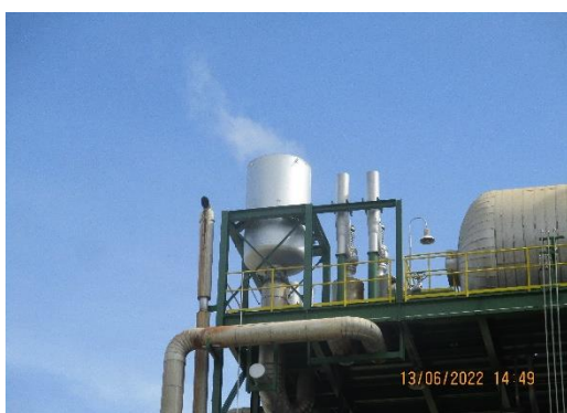
ภาพที่ 2-47 อุปกรณ์ลดระดับเสียงที่แหล่งกำเนิด (Silencer)
