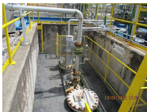
ภาพที่ 2-12 Caustic Drain Drum
