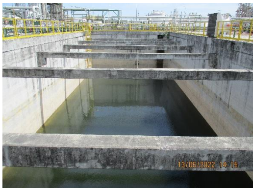
ภาพที่ 2-96 บ่อรวบรวม (Remote Impounding Basin)
