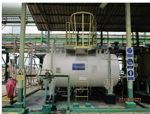
ภาพที่ 2-43 ถังสารเคมีปรับค่าความเป็นกรด-ด่าง
