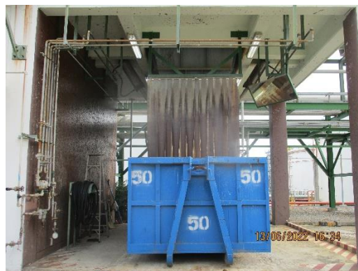
ภาพที่ 2-50 Sludge Hopper น้ำเสีย
