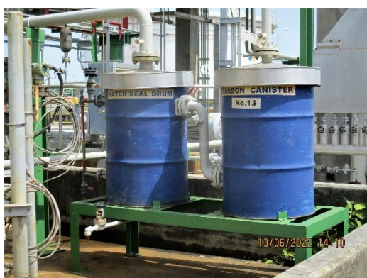
ภาพที่ 2-11 Carbon Canister ที่ Oily Water Drain Drum
