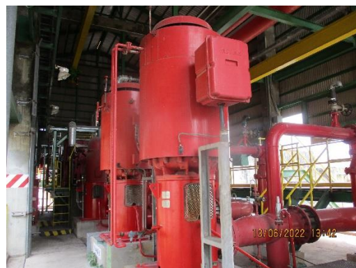
ภาพที่ 2-84 Fire Water Pump
