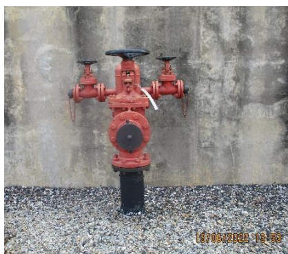
ภาพที่ 2-57 Fire Hydrant
