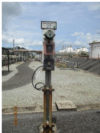
ภาพที่ 2-75 Fire Alarm Call Point
