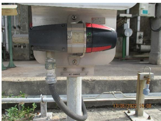
ภาพที่ 2-98 Hydrocarbon Gas Detector
