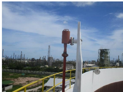
ภาพที่ 2-82 Fixed Foam Chamber
