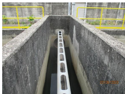
ภาพที่ 2-34 Oil Separator บริเวณลานถังเก็บแนฟทา (TK-1000C)
