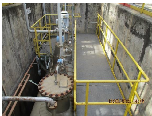
ภาพที่ 2-10 Oily Water Drain Drum
