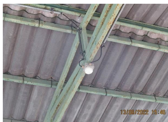
ภาพที่ 2-54 Smoke Detector
