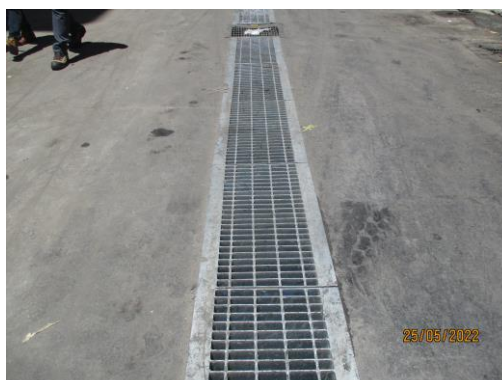
รูปที่ 14 รางระบายน้ำบริเวณพื้นที่ก่อสร้าง
