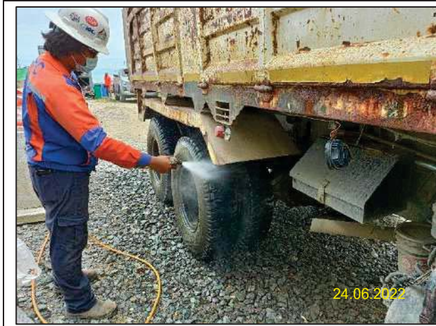
รูปที่ 2-7 การล้างทำความสะอาดเศษดิน และเศษโคลนที่ติดกับล้อรถก่อนออกจากบริเวณพื้นที่ก่อสร้าง
