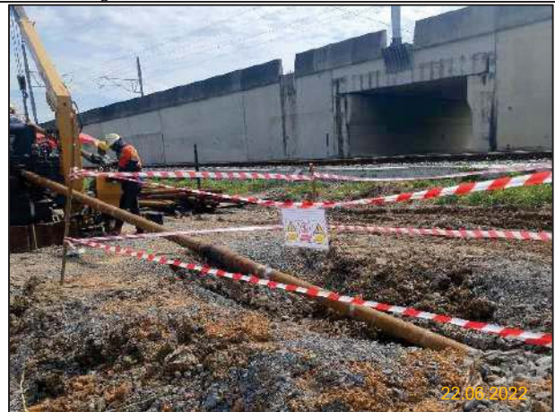
ง) งานวางท่อด้วยวิธีเจาะลอด (HDD)
