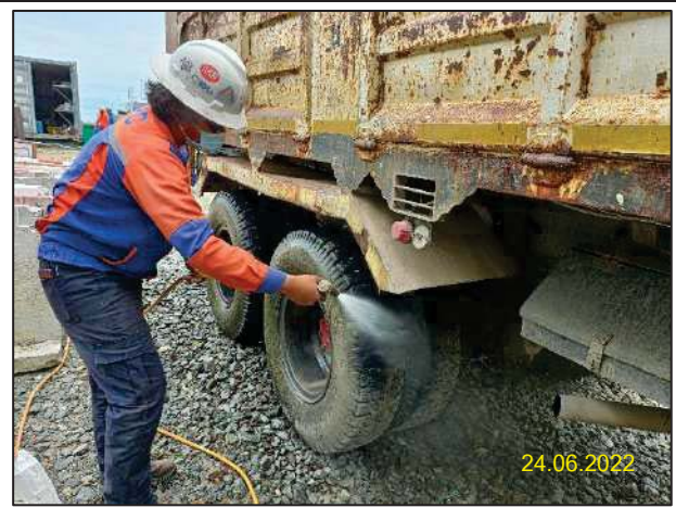
รูปที่ 2-7 การล้างทำความสะอาดเศษดิน และเศษโคลนที่ติดกับล้อรถก่อนออกจากบริเวณพื้นที่ก่อสร้าง
