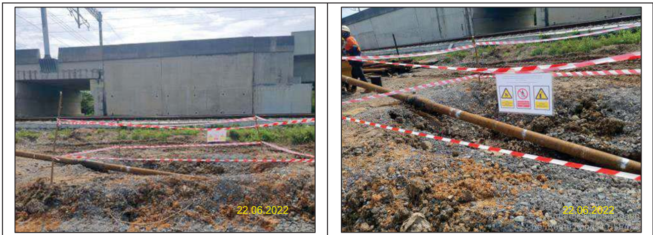
รูปที่ 2-15 การทำคันดินรอบพื้นที่บ่อรับ-ปล่อย
