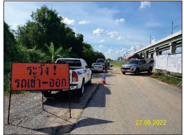
ก) การติดตั้งเครื่องหมายจราจร ป้ายเตือน
