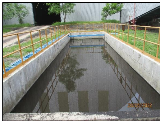
ภาพที่ 2.35 บ่อดักคราบน้ำมันและไขมัน (Oil Separator)
