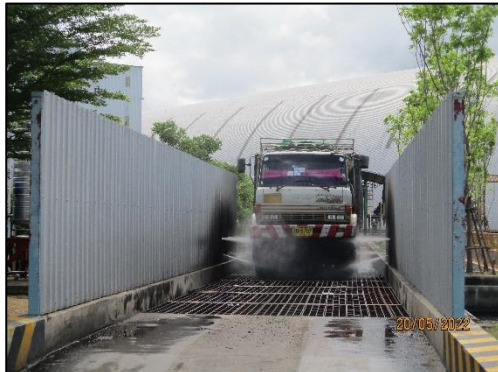
ภาพที่ 2.9 บ่อล้างล้อรถบรรทุกก่อนออกจากพื้นที่โครงการ
