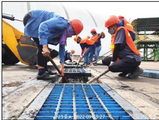
ภาพที่ 2.37 การขุดลอกระบบระบายน้ำภายในพื้นที่โครงการ
