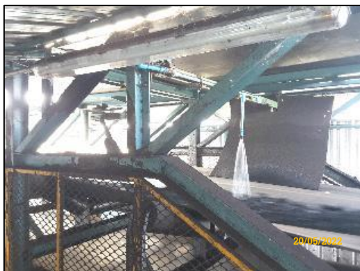
ภาพที่ 2.48 การฉีดพรมน้ำหรือสเปรย์น้ำบริเวณสายลำเลียงและกองเก็บถ่านหิน
