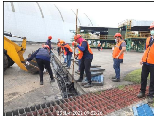
ภาพที่ 2.37 การขุดลอกระบบระบายน้ำภายในพื้นที่โครงการ
