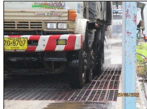
ภาพที่ 2.9 บ่อล้างล้อรถบรรทุกก่อนออกจากพื้นที่โครงการ
