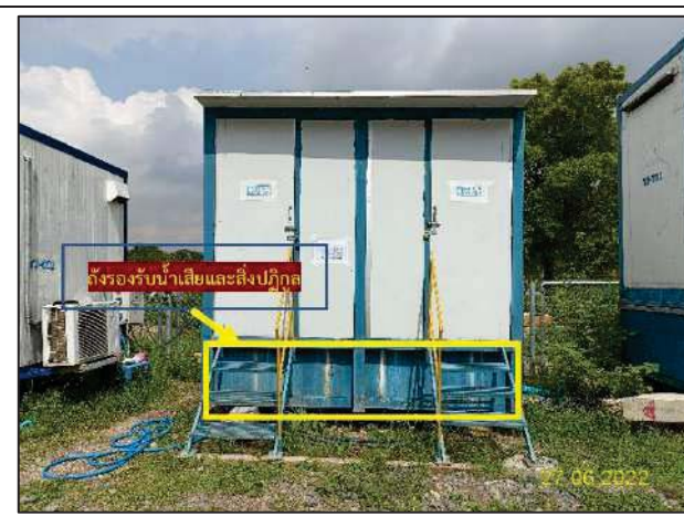
รูปที่ 2-6 ห้องน้ำและถังรองรับน้ำเสียและสิ่งปฏิกูลในบริเวณพื้นที่ตั้งสำนักงานชั่วคราว/พื้นที่เก็บกองท่อ
