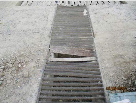
รูปที่ 2-6 รางระบายน้ำรอบพื้นที่ก่อสร้าง
