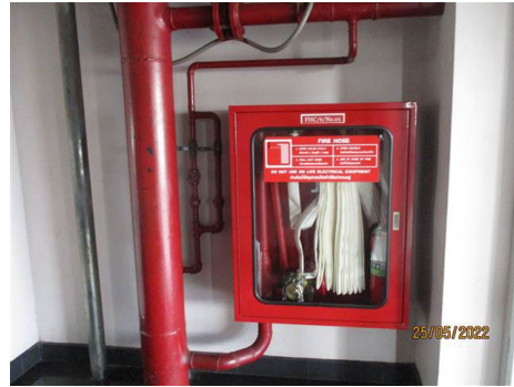
ตู้หัวฉีดน้ำดับเพลิง พร้อมถังน้ำยาเคมี
