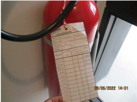
รูปที่ 2-62 การตรวจสอบถังดับเพลิง
