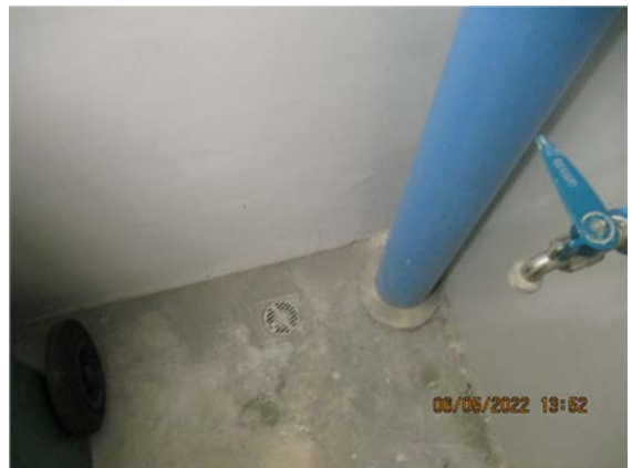
รูปที่ 2-36 ท่อรวบรวมน้ำเสียในห้องพัสดุฝอยรวม
