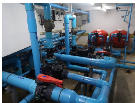
รูปที่ 11 ระบบฆ่าเชื้อโรคชนิด Salt Chlorination
