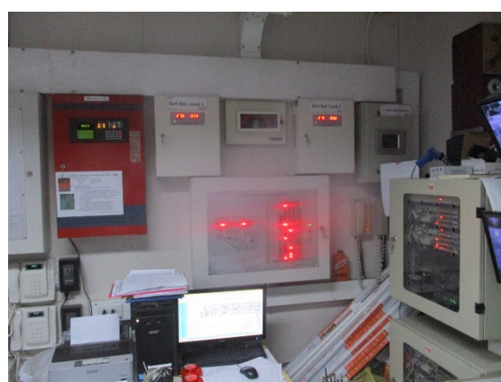
แผงควบคุม (Fire Alarm Control Panel)
