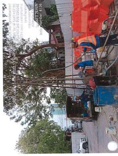
บริเวณ Vb7202งานHddซ่อมแซมแนวท่อข้ามFpt
