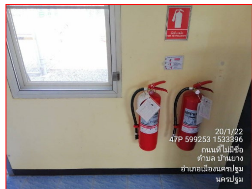
อุปกรณ์ดับเพลิงในสถานีควบคุมก๊าซ RA 3
