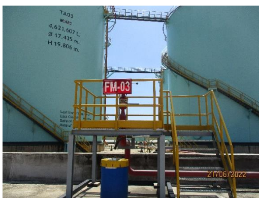
ภาพที่ 2-24 ระบบฉีดน้ำดับเพลิงแบบโฟมและระบบผสมโฟมสำหรับดับเพลิง
