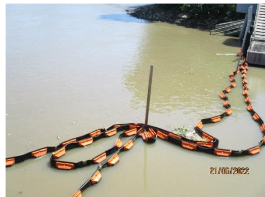
ภาพที่ 2-8 การควบคุมการรั่วไหลของน้ำมันระหว่างการขนถ่าย
