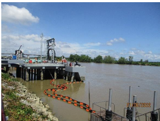
ภาพที่ 2-8 การควบคุมการรั่วไหลของน้ำมันระหว่างการขนถ่าย
