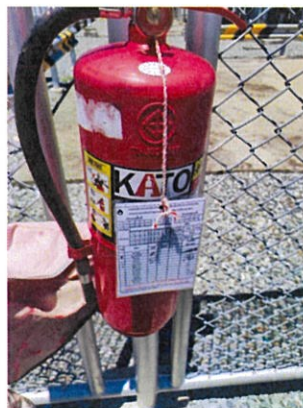
ภาพที่ 2-3 ถังดับเพลิงแบบเคมีผง และ Tag ตรวจสอบถังดับเพลิงแบบเคมีผง
