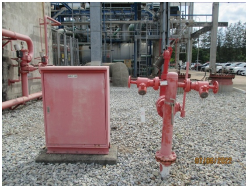
ท่อน้ำดับเพลิงและหัวจ่ายน้ำดับเพลิงรอบพื้นที่โรงไฟฟ้า
