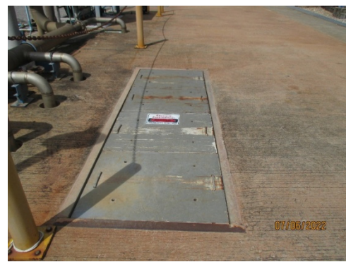
รูปที่ 3-10 Inspection Manhole
