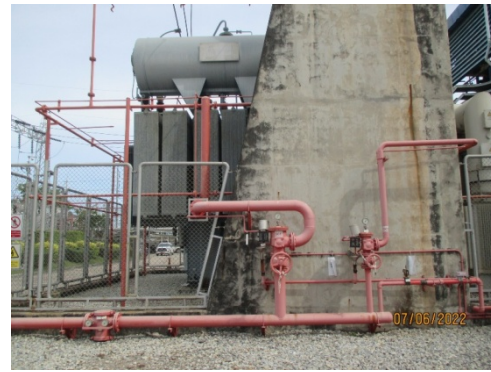
ท่อน้ำดับเพลิงและหัวจ่ายน้ำดับเพลิงรอบพื้นที่โรงไฟฟ้า
