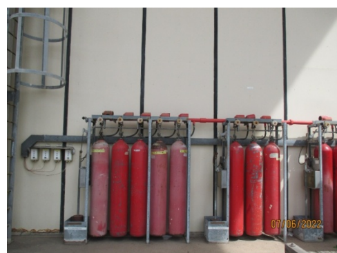
Fire Extinguisher ชนิด Carbon Dioxide
