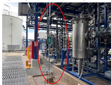
ภาพที่ 2-48 ฝักบัวอาบน้ำฉุกเฉิน และที่ล้างตาฉุกเฉิน
