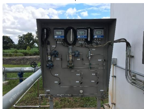
ภาพที่ 2-20 ระบบตรวจวัดคุณภาพน้ำแบบต่อเนื่อง (Online Monitor) บริเวณอ่างเก็บน้ำทิ้ง
