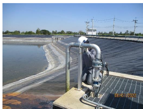
ภาพที่ 2-22 บ่อรวบรวมน้ำ (Sump) บริเวณอ่างเก็บน้ำทิ้ง
