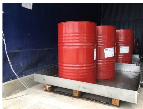
ภาพที่ 2-32 ถังรองรับน้ำมันใช้แล้ว
