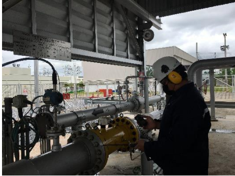
ภาพที่ 2-51 ตรวจสอบการรั่วไหลของท่อโดย Gas detector
