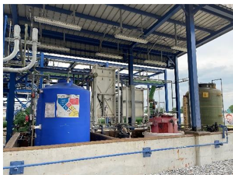
ภาพที่ 2-49 คันกั้นสารเคมีทกรั่วไหล
