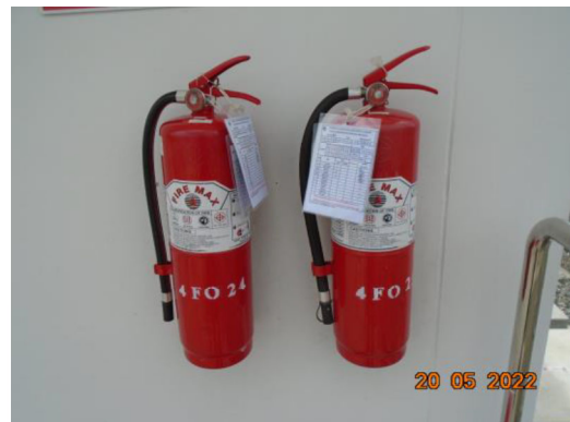
ภาพที่ 2-2 ถังดับเพลิงแบบเคมีผง และป้ายแสดงการตรวจสอบสภาพถังดับเพลิง บริเวณสถานีควบคุมความดันและวัดปริมาณก๊าซธรรมชาติ (MRS)
