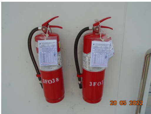
ภาพที่ 2-2 ถังดับเพลิงแบบเคมีผง และป้ายแสดงการตรวจสอบสภาพถังดับเพลิง บริเวณสถานีควบคุมความดันและวัดปริมาณก๊าซธรรมชาติ (MRS)
