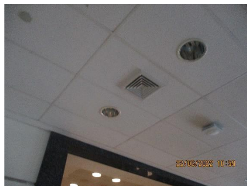
รูปที่ 2-12 ติดตั้งอุปกรณ์จับควัน และตัวจับความร้อน
