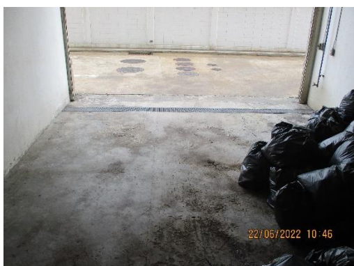
รูปที่ 2-3 รางระบายน้ำจากห้องพักรวมมูลฝอย
