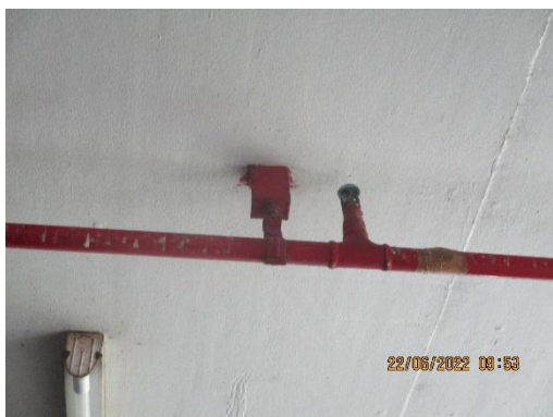
ช) ระบบดับเพลิงอัตโนมัติแบบโปรยน้ำฝอย รูปที่ 2-13 (ต่อ) ติดตั้งระบบดับเพลิง
