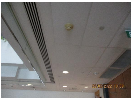
รูปที่ 2-12 ติดตั้งอุปกรณ์จับควัน และตัวจับความร้อน
