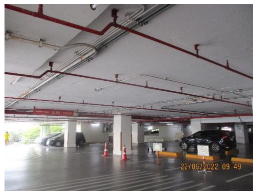
ช) ระบบดับเพลิงอัตโนมัติแบบโปรยน้ำฝอย รูปที่ 2-13 (ต่อ) ติดตั้งระบบดับเพลิง
