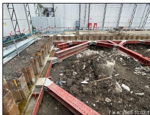
ภาพที่ 24 Sheet pile
