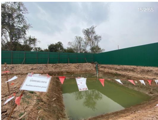
รูปที่ 3.1-28 บ่อดักตะกอนน้ำชั่วคราว ภายในพื้นที่โครงการ
