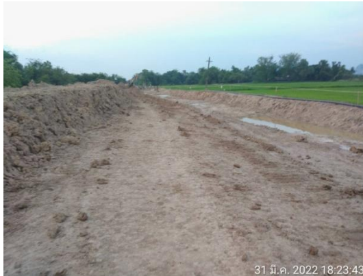
รูปที่ 3.2-1 การฝังกลบเมื่อวางท่อส่งน้ำดิบและท่อน้ำทิ้งแล้วเสร็จ
