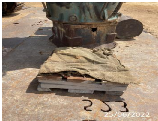
รูปที่ 3.1-14 ไม้หมอนและกระสอบรองหัวเสาเข็ม
