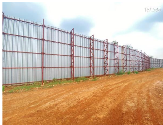
รูปที่ 3.1-13 กำแพงกันเสียงชั่วคราวบริเวณบ้าน หลังโรงไฟฟ้า (ด้านทิศใต้ของโครงการ)
