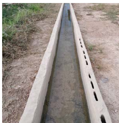
รูปที่ 3-22 ร่องระบายน้ำสำหรับรองรับน้ำเสีย จากกิจกรรมก่อสร้าง
