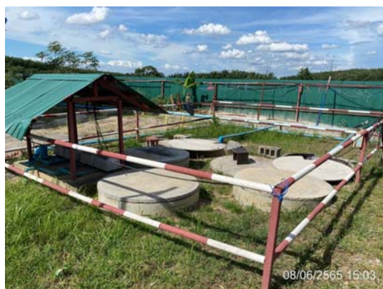
รูปที่ 3-26 ระบบบำบัดน้ำเสียสำเร็จรูป บริเวณบ้านพักคนงาน
