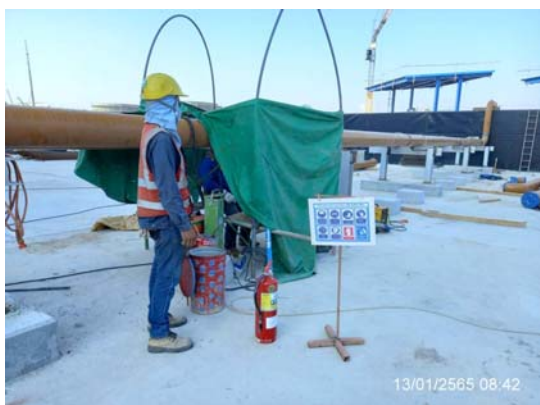
รูปที่ 3-65 พื้นที่เชื่อมต่อบรรบบท่อส่งก๊าซธรรมชาติและท่อส่งน้ำมัน
