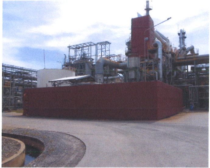
การติดตั้งแผ่นกันเสียงดังจากเครื่องจักร 4140-B1-T1
