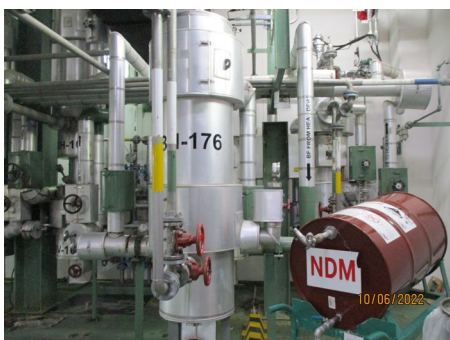
ภาพที่ 2-7 BH 176 Coloring Mixing Storage Tank (ชั้น 3)
