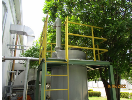
ภาพที่ 2-25 ระบบ Carbom Absorber
