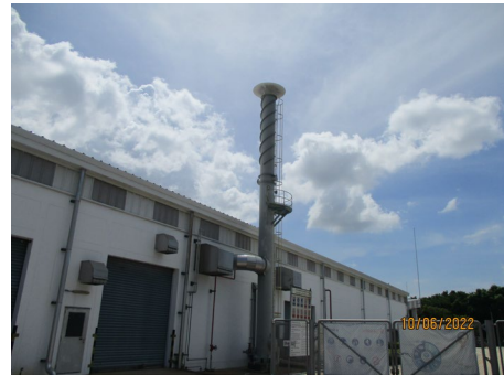
ภาพที่ 2-2 ปล่อง Turbulent Dust Collector
