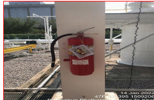
การติดตั้งถังดับเพลิงสถานีควบคุมก๊าซ
