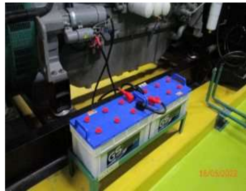
รูปที่ 3-66 แบตเตอรี่สำรอง
