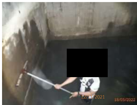
รูปที่ 3-52 ล้างถังเก็บน้ำใช้
