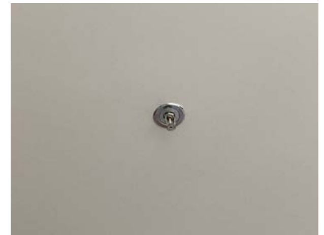
รูปที่ 3-25 หัวกระจายน้ำดับเพลิง
