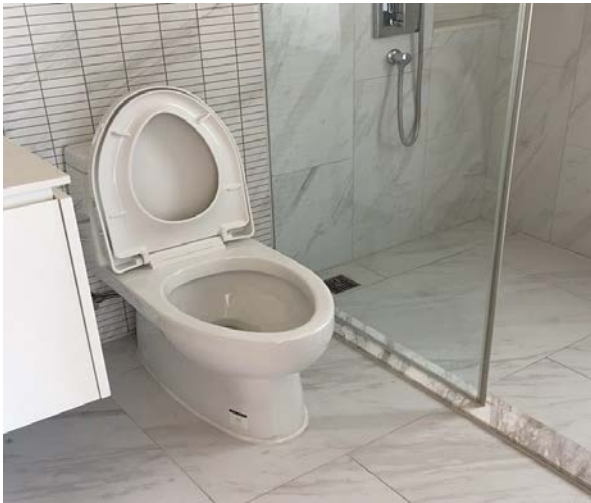
รูปที่ 3-14 เครื่องสุขภัณฑ์สำหรับห้องน้ำ/ห้องส้วมแบบ ประหยัดน้ำ
