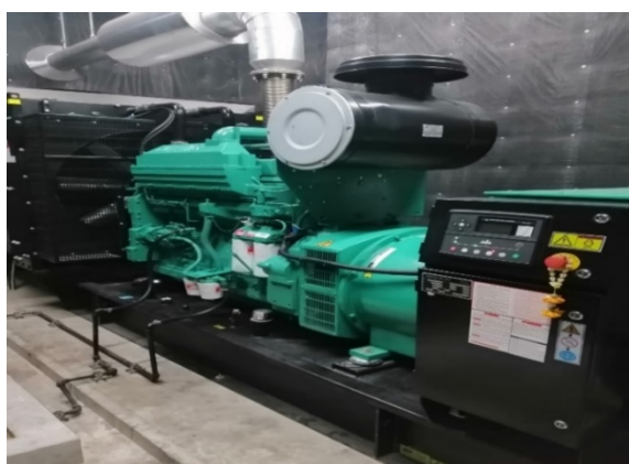
รูปที่ 2.4-8 เครื่องกำเนิดไฟฟ้าสำรอง (Generator 625 kVA.)
