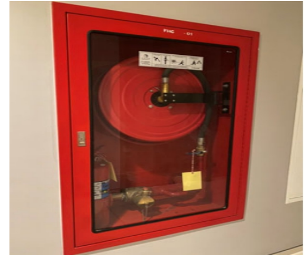
รูปที่ 3-28 ตู้เก็บสายฉีดน้ำดับเพลิง
