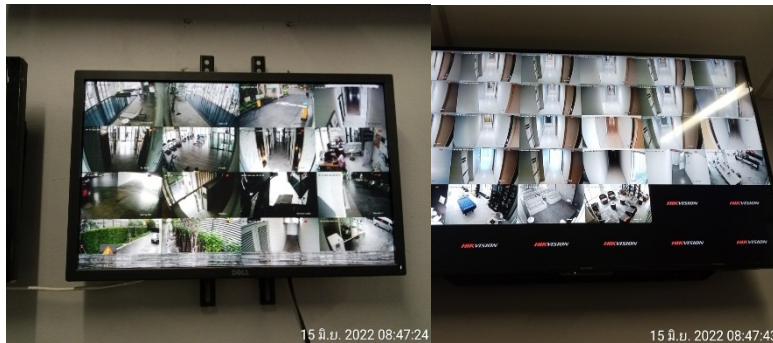
รูปที่ 2.4-13 ระบบกล้องวงจรปิด
