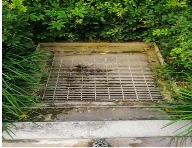
รูปที่ 3-8 ตะแกรงดักมูลฝอยที่บ่อพักน้ำสุดท้าย
