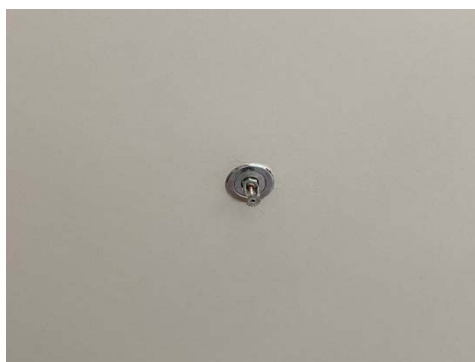
รูปที่ 2.4-11 หัวกระจายน้ำดับเพลิง
