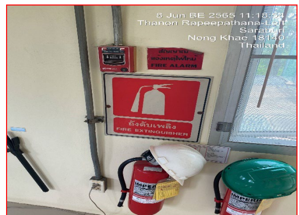
อุปกรณ์ดับเพลิงภายในสถานีควบคุมก๊าซ
