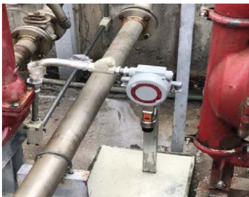
ภาพที่ 1 Gas detector ที่บริเวณถังเก็บสารเมทานอล
