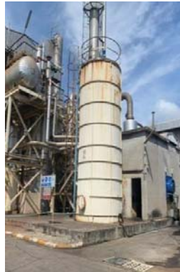
ภาพที่ 8 ถึงเก็บกักน้ำขนาด 75 ลบ.ม.
