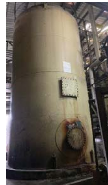
ภาพที่ 8 ถึงเก็บกักน้ำขนาด 75 ลบ.ม.
