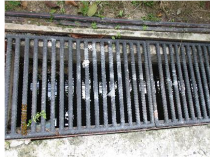
ภาพที่ 2.2-40 ตะแกรงครอบตามรูท่อระบายน้ำ
