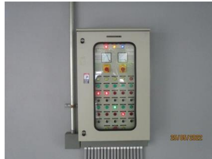
ภาพที่ 2.2-11 ระบบมิเตอร์ไฟฟ้าสำหรับระบบบำบัดน้ำเสีย
