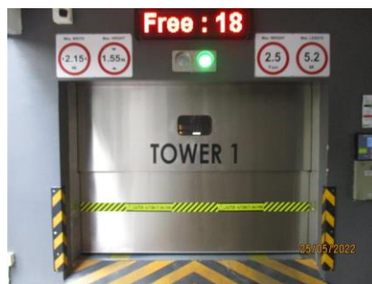
ภาพที่ 2.2-34 ระบบจอดรถอัตโนมัติ และมีผนังที่กันไฟ
