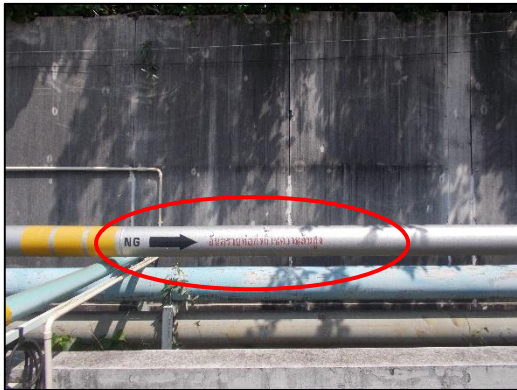
ภาพที่ 6 ข้อความบ่งชี้อันตรายตามแนวท่อส่งก๊าซ
