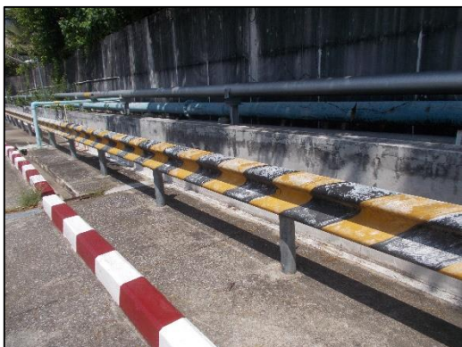
ภาพที่ 9 การติดตั้งราวเหล็กกันชน
