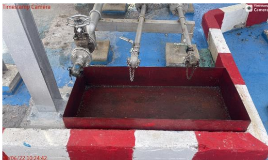
ภาพที่ 2-5 ถาดรองน้ำมันที่อาจหกรั่วไหลจากการถอดท่อและข้อต่อในการขนถ่ายน้ำมันที่ทำเรือ
