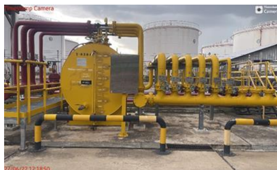
ภาพที่ 2-10 อุปกรณ์ดับเพลิงภายในคลัง
