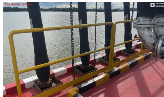
ภาพที่ 2-5 ถาดรองน้ำมันที่อาจหกรั่วไหลจากการถอดท่อและข้อต่อในการขนถ่ายน้ำมันที่ทำเรือ
