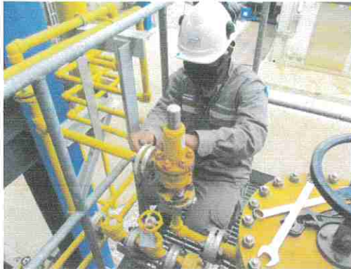
รูปที่ 1 การทดสอบกลอุปกรณ์นิรภัย
