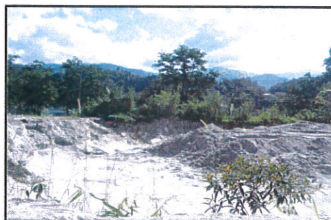
(39) อ่างดักตะกอนที่ 5 (ขนาดความจุ 10,000 ลบ.ม)
