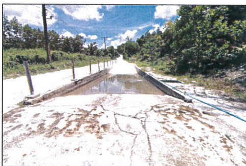
(23) บ่อล้างล้อรถบรรทุกก่อนจากพื้นที่โครงการ
