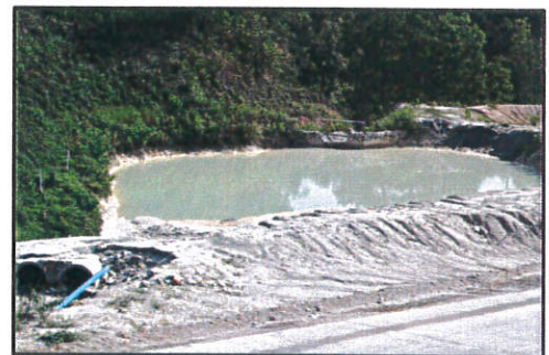
(36) อ่างดักตะกอนบริเวณลานสต็อกวัตถุดิบ (อ่างดักตะกอนที่ 2 ขนาดความจุ 5,400 ลบ.ม)
