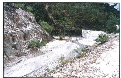
(46) อ่างดักตะกอนที่ 12 ไกล่ South Dump ขนาดความจุ 2,250 ลบ.ม.
