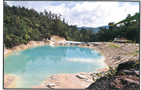
(42) อ่างดักตะกอนที่ 8 บริเวณที่ทิ้งดิน ด.3 ขนาดความจุ 6,000 ลบ.ม.
