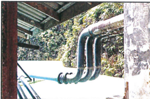
(53) ท่อระบายน้ำจากบ่อดักตะกอนคอนกรีตลงสู่อ่าง เก็บน้ำหมุนเวียน (อ2)
