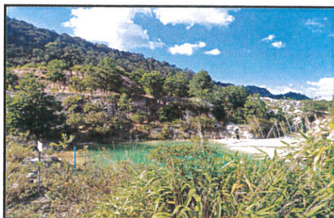
(47) อ่างดักตะกอนที่ 13 ไกล่หน้าเหมือง 2D ขนาดความจุ 10,000 ลบ.ม.
