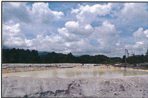
(37) อ่างดักตะกอนบริเวณลานสต็อกวัตถุดิบ (อ่างดักตะกอนที่ 3 ขนาดความจุ 23,375 ลบ.ม)
