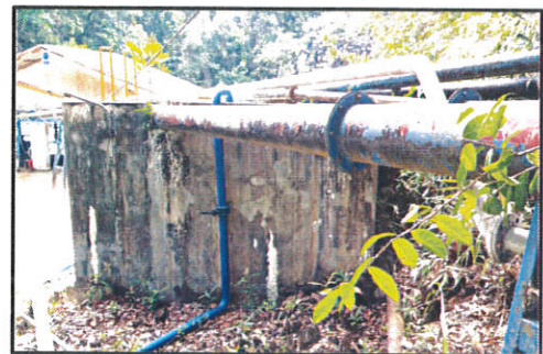
(52) ท่อระบายน้ำจากโรงแต่งที่ลงบ่อดักตะกอน คอนกรีต
