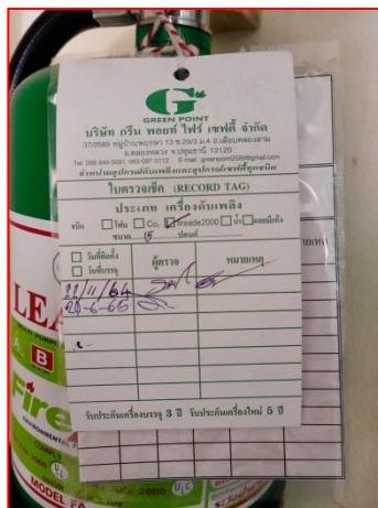
ภาพที่ 2.2-36 การตรวจสอบสภาพอุปกรณ์ดับเพลิงโดยบริษัทผู้จำหน่าย
