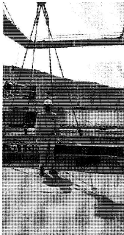
ภาพแสดงการ Test Load ของGantry Crane 30 Tons. (D-3)
