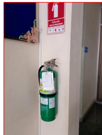
ภาพที่ 2.2-36 การตรวจสอบสภาพอุปกรณ์ดับเพลิงโดยบริษัทผู้จำหน่าย
