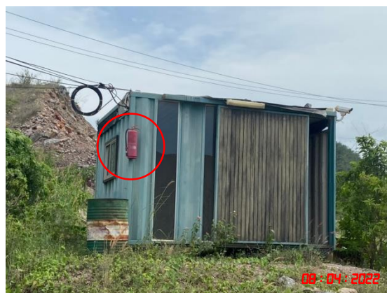
รูปที่ 2-26 การติดตั้งถังดับเพลิงตามจุดต่างๆ ในพื้นที่โครงการ
