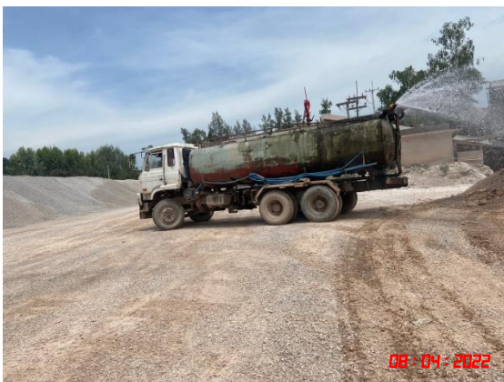
รูปที่ 2-8 การฉีดพรมน้ำบริเวณโรงโม่หิน และเส้นทางลำเลียงหิน
