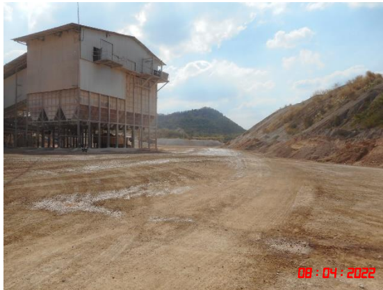
รูปที่ 2-7 ลานเก็บกองแร่ที่เป็นลานหินบดอัดแน่น
