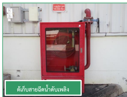
ภาพที่ 2-27 การติดตั้งอุปกรณ์ดับเพลิงภายในพื้นที่โครงการฯ
