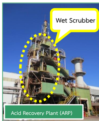
ภาพที่ 2-3 ระบบควบคุมมลสาร (Scrubber) ของ Acid Recovery Plant (ARP) และ Pickling Line (PL)
