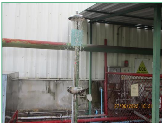
ภาพที่ 2.31 การติดตั้งฝักบัวฉุกเฉินและอ่างล้างตาฉุกเฉินภายในโครงการฯ
