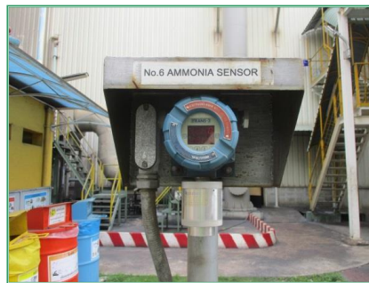
ภาพที่ 2-33 การติดตั้ง Gas Detector ภายในโครงการฯ
