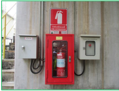
ภาพที่ 2-39 ถังดับเพลิงชนิดผงเคมีแห้ง บริเวณพื้นที่จัดเก็บแอมโมเนีย
