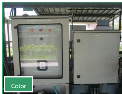
ภาพที่ 2-8 บ่อตรวจคุณภาพน้ำเสียแบบอัตโนมัติ ก่อนระบายเข้าสู่ระบบบำบัดน้ำเสียส่วนกลาง ของนิคมอุตสาหกรรมดับบลิวเอชเอ ตะวันออก (มาบตาพุด)
