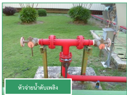
ภาพที่ 2-27 การติดตั้งอุปกรณ์ดับเพลิงภายในพื้นที่โครงการฯ
