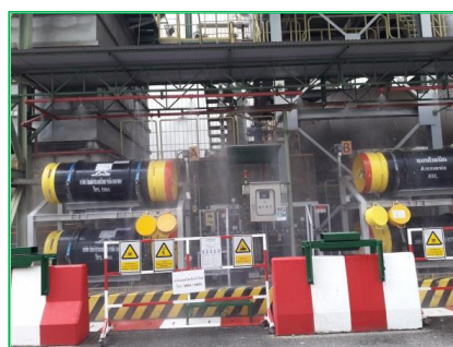
ภาพที่ 2-38 ระบบสเปรย์น้ำบริเวณถังแอมโมเนีย
