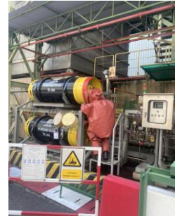
ภาพที่ 6 OC สั่งการให้ DeNOx Technician และ Mill Technician เข้าทำการปิดวาล์วที่ Drum ของถังแอมโมเนียที่ Ammonia Station
