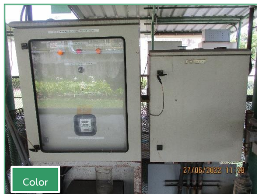
ภาพที่ 2.8 บ่อตรวจคุณภาพน้ำเสียแบบอัตโนมัติ ก่อนระบายเข้าสู่ระบบบำบัดน้ำเสีย ส่วนกลางของนิคมอุตสาหกรรมดับบลิวเอชเอ ตะวันออก (มาบตาพุด)
