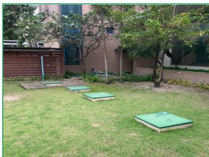
ภาพที่ 2-9 ถังบำบัดน้ำเสียสำเร็จรูปชนิดติดตั้งกับที่
