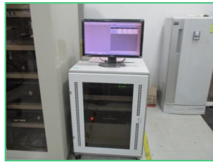
ภาพที่ 2-2 ระบบตรวจวัด NOx จากปล่องแบบต่อเนื่อง (Continuous Emission Monitoring System : CEMs)
