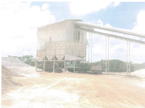
รูปที่ 19 การปิดคลุมอาคารโรงโม่หิน ชุด Product Screen
