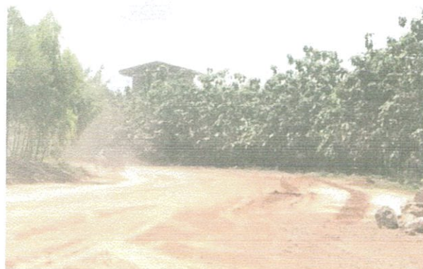
รูปที่ 16 ปลุกต้นไม้สองข้างทางขึ้น Ramp ช่วยลดฝุ่นละอองขณะขนส่งหิน
