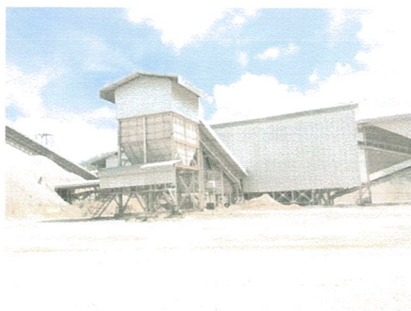
รูปที่ 18 การปิดคลุมอาคารโรงโม่หิน ชุด Secondary & Tertiary Crusher
