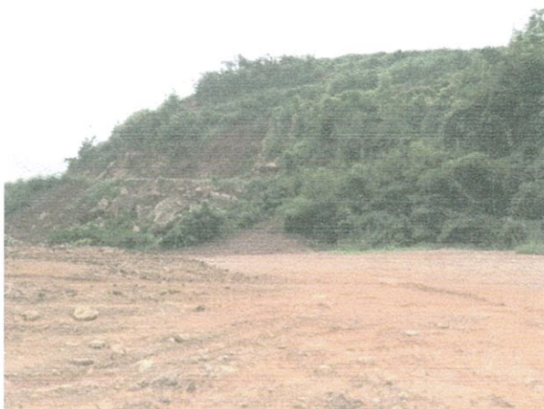
รูปที่ 3 ระหว่างแนวเส้นทางที่ต้องตัดขึ้นสู่ยอดเขา ทอยเปิดหน้างานบางส่วนให้เป็นชั้นบันได
