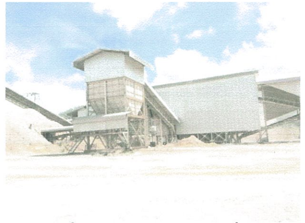
รูปที่ 16 การปิดคลุมอาคารโรงโม่หิน ชุด Secondary & Tertiary Crusher
