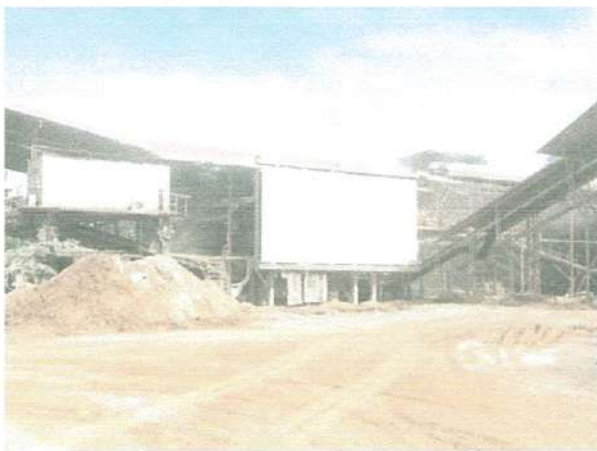
รูปที่ 14 การปิดคลุมอาคารโรงโม่หิน ชุด Secondary & Tertiary Crusher
