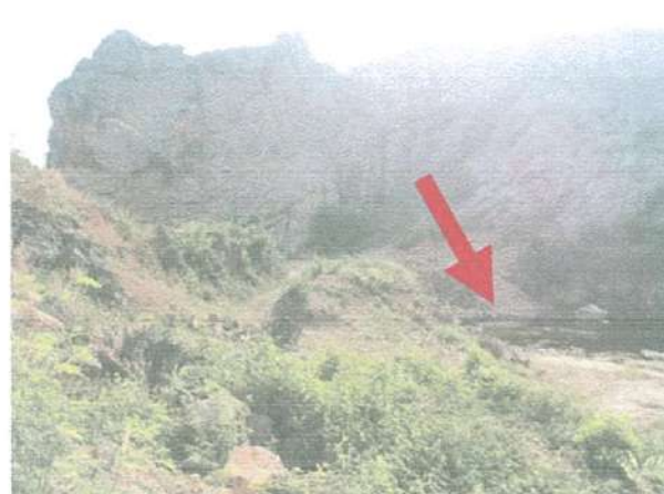
รูปที่ 6 สภาพน้ำท่วมขังบริเวณหน้างานก่อนซึมลงสู่ชั้นใต้ดินไปรวมกับ Sump ของประต่านบัตรข้างเคียง
