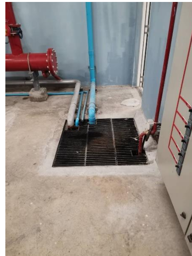
ภาพที่ 2.7 ท่อรวบรวมน้ำฝนลงบ่อหน้า และถังเก็บน้ำใต้ดิน
