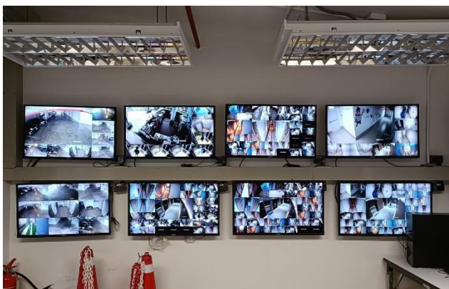
ภาพที่ 2.41 ระบบจอมอนิเตอร์กล้องโทรทัศน์วงจรปิด (CCTV)
