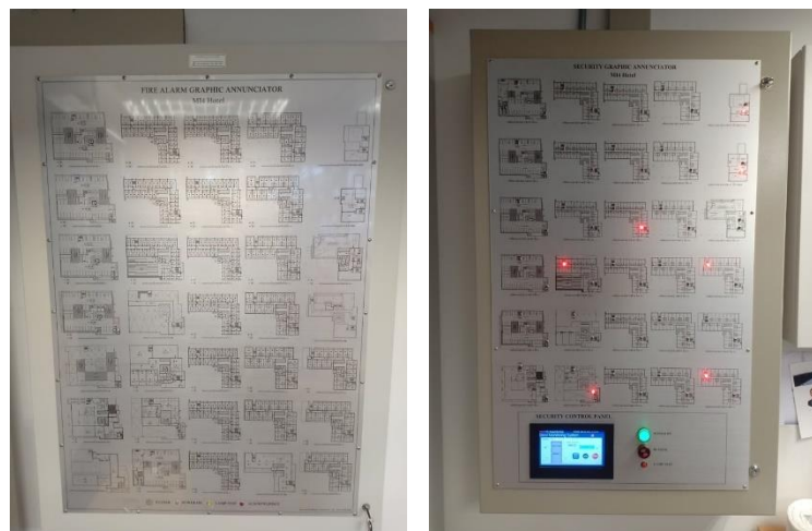
ภาพที่ 2.37 Fire Alarm System
