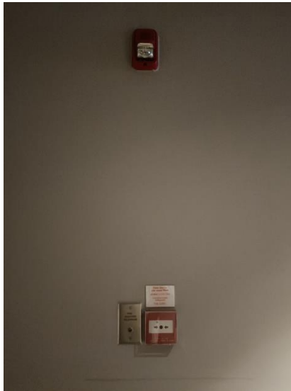
ภาพที่ 2.19 สัญญาณแจ้งเตือนเหตุเพลิงไหม้
