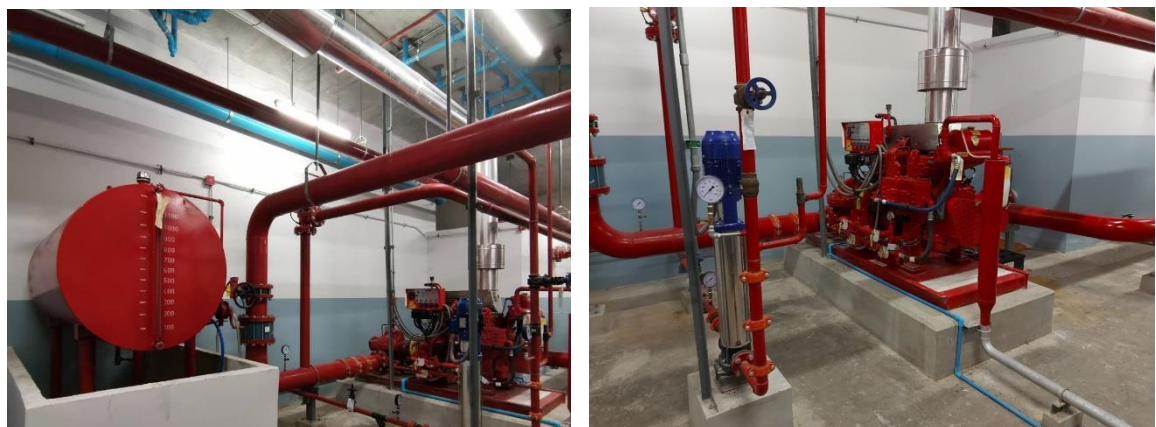
ภาพที่ 2.38 Fire Water Pump
