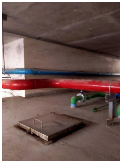
ภาพที่ 2.7 ท่อรวบรวมน้ำฝนลงบ่อหน้า และถังเก็บน้ำใต้ดิน
