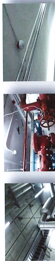
1.2 เครื่องตรวจจับความร้อน (Heat Detector) ติดตั้งบริเวณห้องเครื่องปั่นไฟ ห้องเครื่องสูบน้ำ รัตดาการ ห้องน้ำ และที่จอดรถ มีจำนวนทั้งสิ้น 23 จุด
