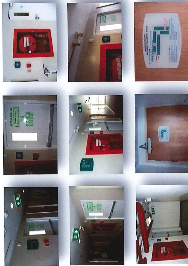
1.3 เครื่องแจ้งเหตุโดยอัตโนมัติ (Fire Alarm Manual Station) สำหรับส่งสัญญาณเตือนไฟ โดยจะติดตั้งอยู่บริเวณด้านหน้าบันได ST-1 และ ST-2 ตั้งแต่ชั้นใต้ดินถึงชั้นที่ 7 จำนวน 2 จุด/ชั้น มีจำนวนรวมทั้งสิ้น 16 จุด
